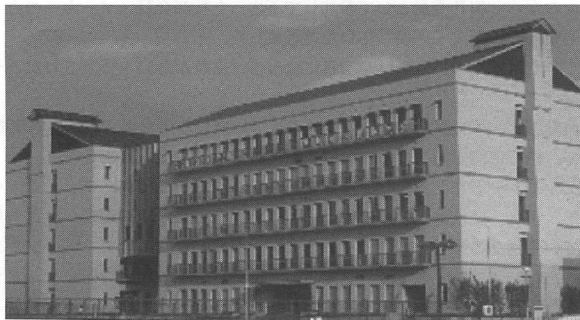
国道169号線側よりみた校舎
